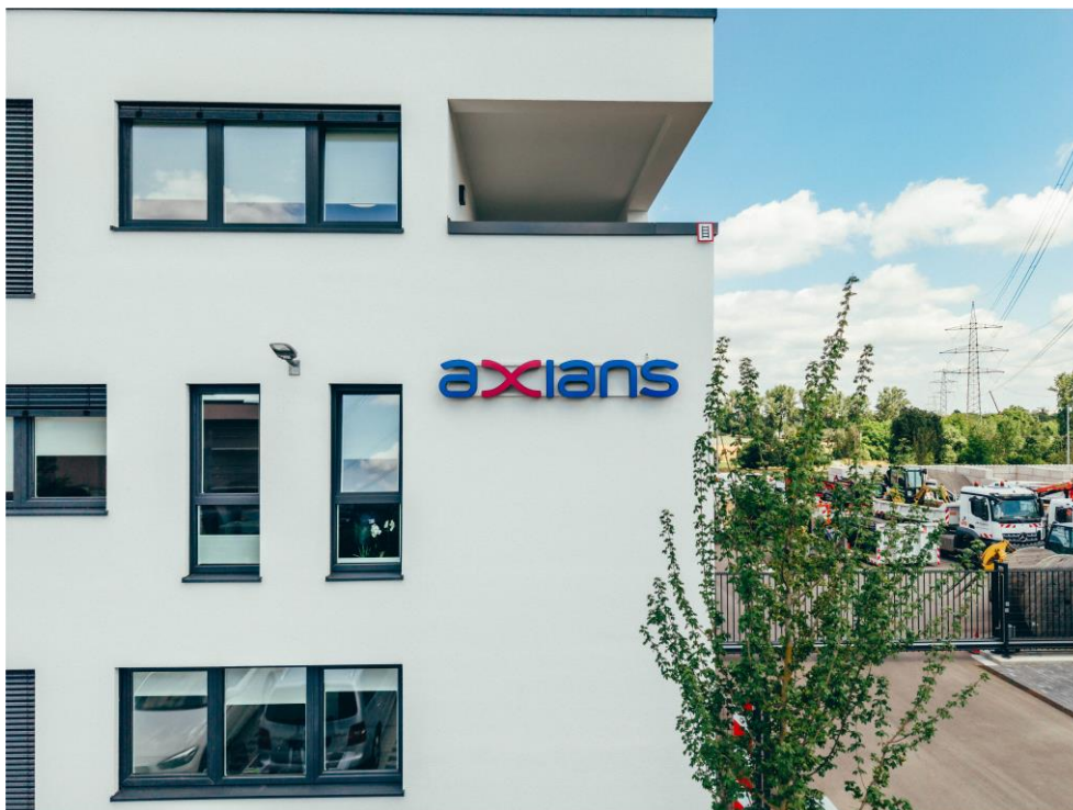
Der neue Axians Bürocampus in Möglingen vereint moderne Arbeitsplätze mit Flächen für Technik, Logistik und Zusammenarbeit Quelle: Axians Deutschland
