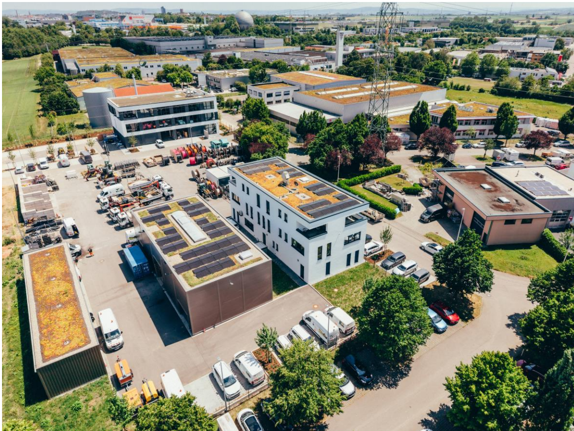
Photovoltaik, begrünte Dächer und Batteriespeicher sorgen für eine energieeffiziente und zukunftsorientierte Nutzung des Standorts, Quelle: Axians Deutschland
